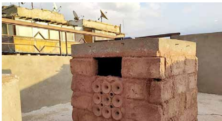
Marwa Dabaieh utvecklar ett passivt kylsystem genom att kombinera lertrattar, vatten samt sol och vind.
